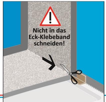
**C 12.** Anschließend mit der Schere die Dichtbahn entlang der Markierung sauber abschneiden.
