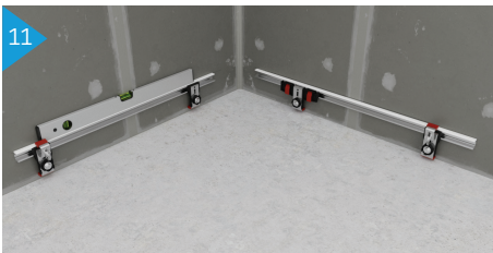
Wandanker mit der Wasserwaage ausrichten und festziehen
