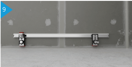
Verlängerung und Wandanker mit Schrauben an der Wand befestigen
