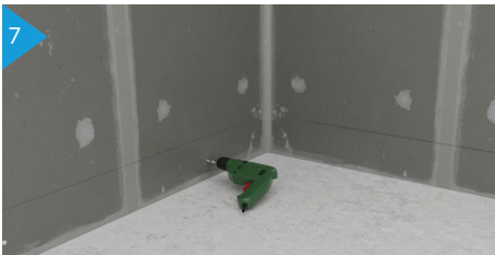
Bohren an den angezeichneten Punkten
