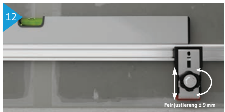
Wandanker mit der Wasserwaage ausrichten und festziehen
