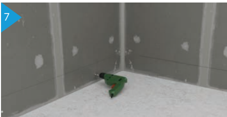
Bohren an den angezeichneten Punkten
