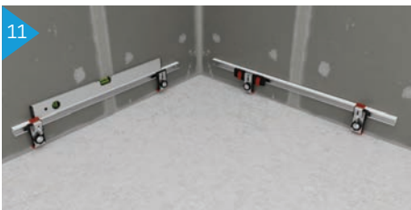
Wandanker mit der Wasserwaage ausrichten und festziehen
