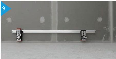
Verlängerung und Wandanker mit Schrauben an der Wand befestigen
