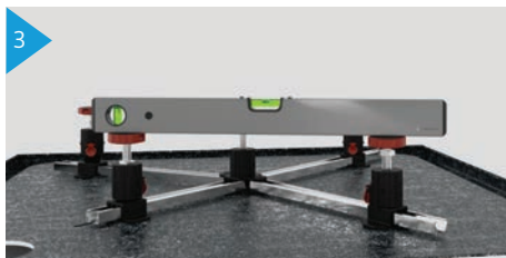
Alle Stellfüße auf die gleiche Höhe ausrichten
