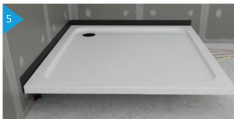
Montierte Duschwanne
