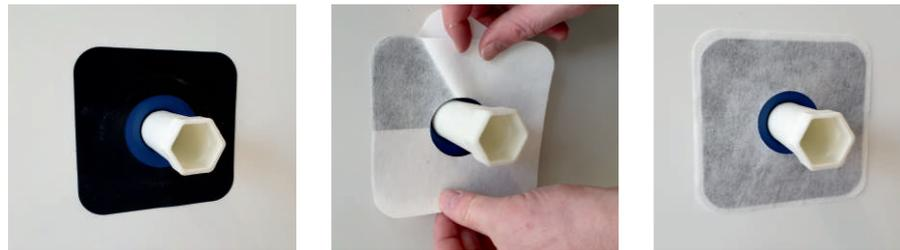
Vliesmanschette überlappend auf die Tropfschutz-Dichtmanschette aufbringen. Schutzfolie entfernen und fest andrücken. Zum Abdichten vorbereitet.
