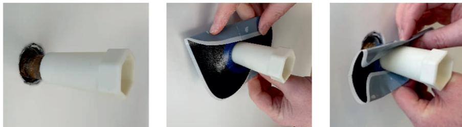
Die TRINNITY Tropfschutz-Dichtmanschette seitlich zur Mitte falten, s. Bilder
