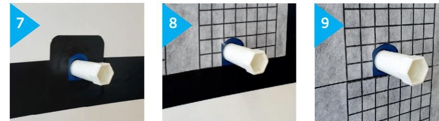
TRINNITY Eckleiband auf die Dichtmanschette verkleben (Bild 7).
