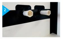
Einen Streifen TRINNITY Eckklebeband überlappend auf die Manschetten verkleben.
